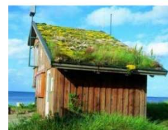
Gründach mit Kanalanschluss
