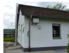
Dachfläche mit Kanalanschluss
