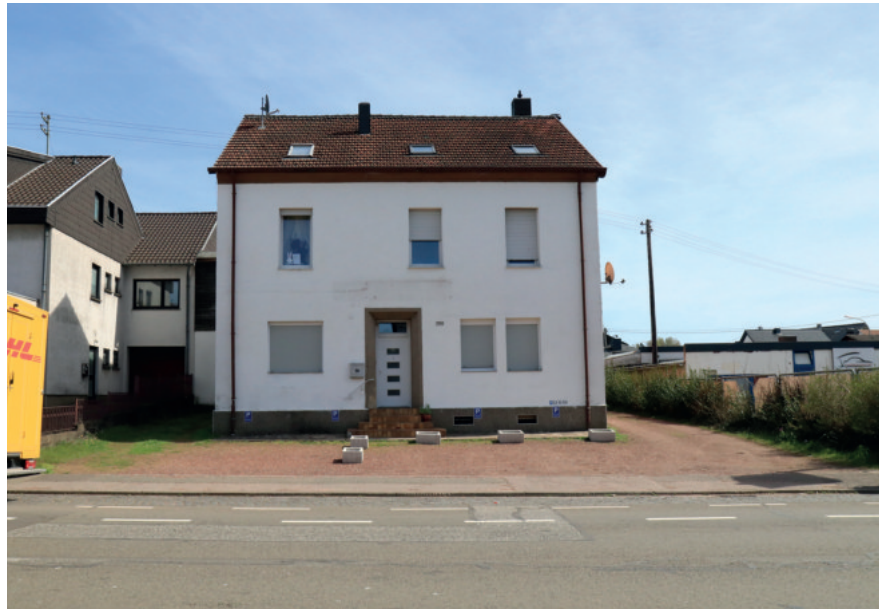
Wohngebäude im Bereich der Provinzialstraße
