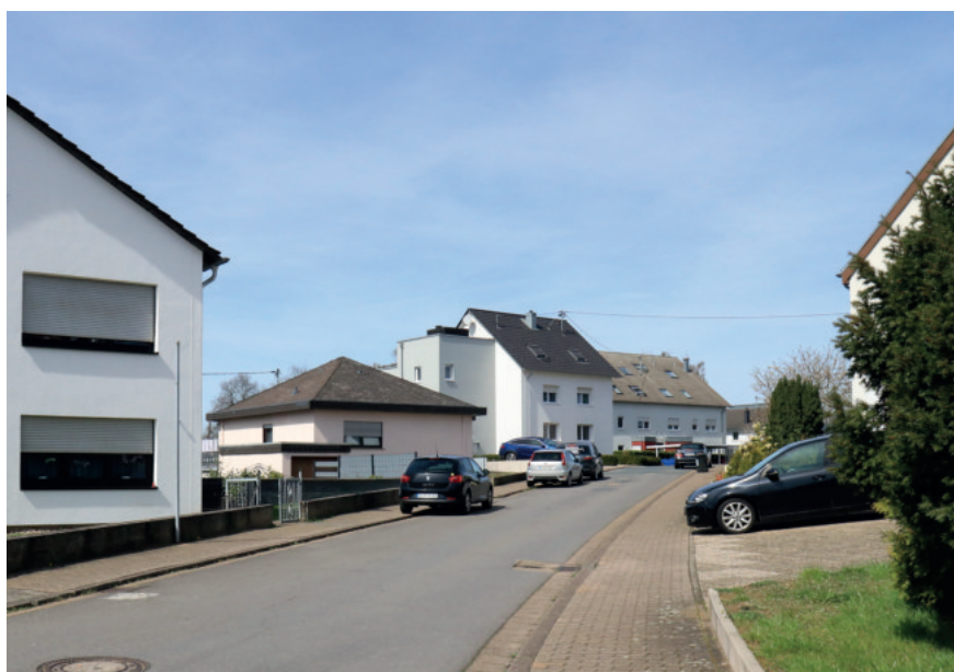
Bebauung im Bereich der „Griesborner Straße“ mit unterschiedlichen Trauf- und Firsthöhen
