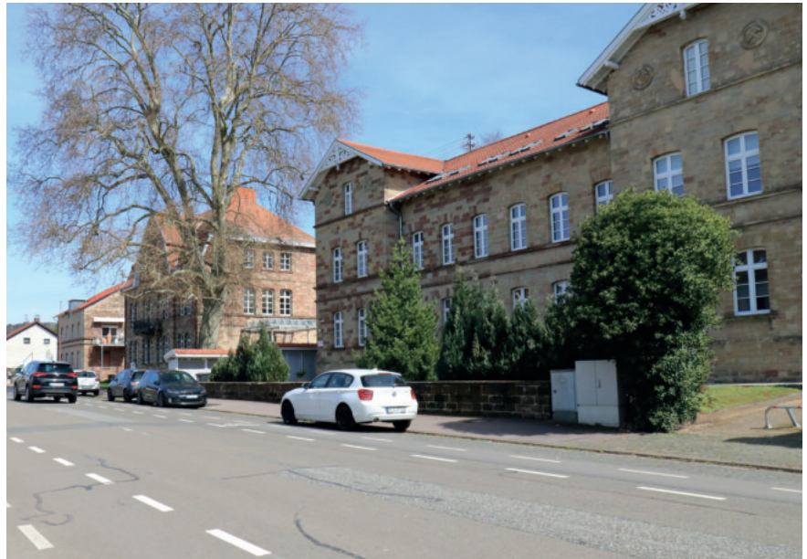
Ortsbildprägende, teils denkmalgeschützte Bebauung im Bereich der Provinzialstraße mit ähnlichen Traufhöhen
