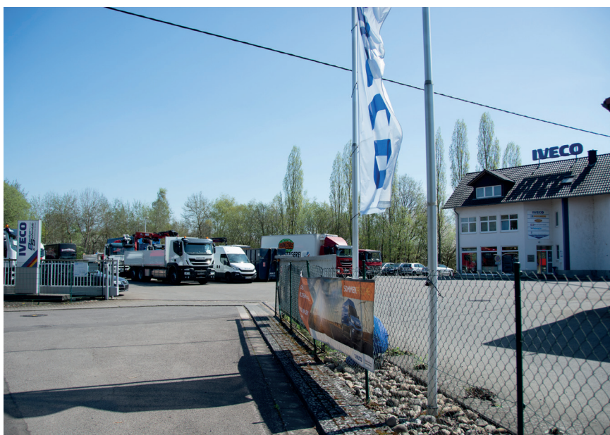
Blick von Westen in den südlichen Bereich des Plangebietes
